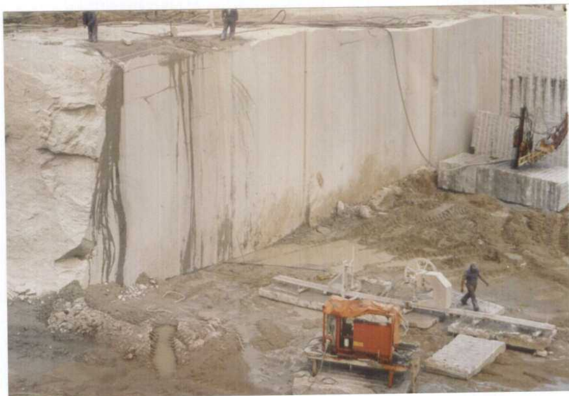
FOTOGRAFIA 15.- Detalle del frente de una explotación de "Blanco Aurora", en la Zona de Taberneros-Sieteiglesias (Madrid).
